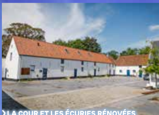
LA COUR ET LES ÉCURIES RÉNOVÉES
