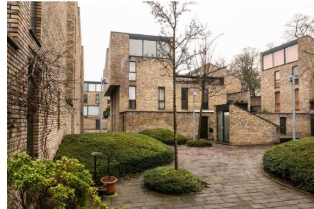
T'Pandreitje à Brugge - Bureau Bouwtechniek
